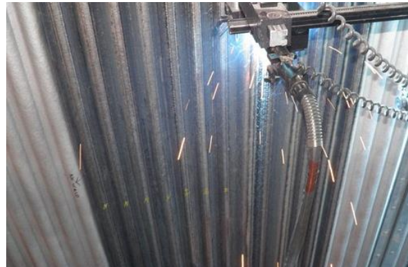
Imagen 2: Weld Overlay en sitio en progreso
